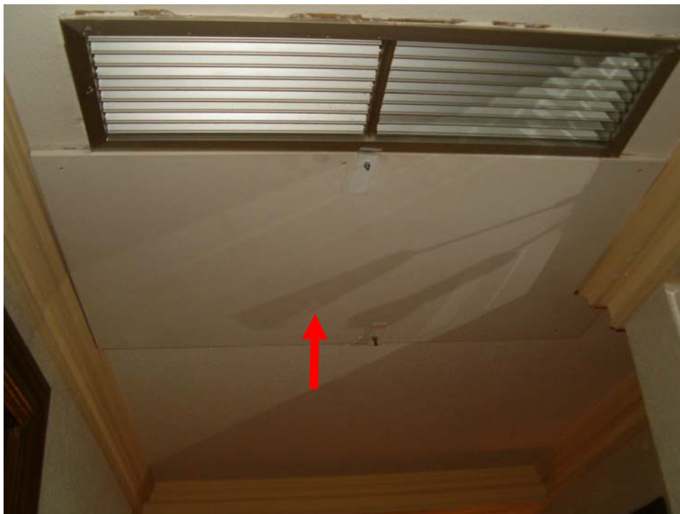
Rejillas de ventilación y trampillas de acceso al equipo. (Fotografías UTCV-Madrid Salud)
