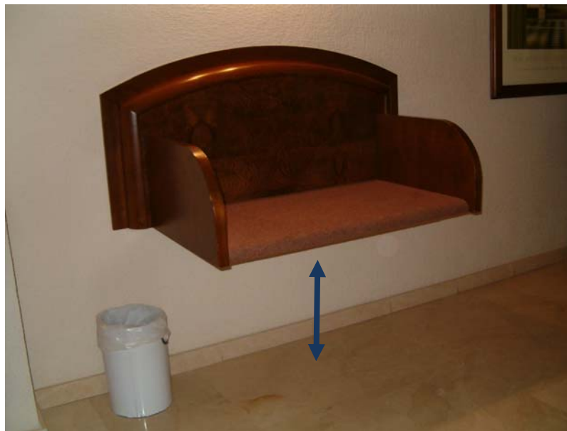
Mueble portamaletas colgante. Bien que la elección del tapizado textil no sea en absoluto recomendable, la solución de colgar el mueble, en combinación con la correcta selección y mantenimiento del material de suelo-rodapié-pared reduce el riesgo de infestación del equipaje. (Fotografía UTCV-Madrid Salud)
