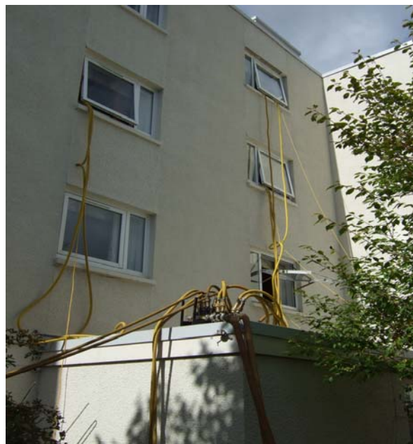
Tratamiento térmico de habitaciones; unidad térmica (exterior) y elementos de distribución. (Fotografías Rentokil-España)
