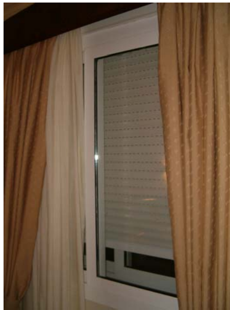
Ventana (PVC). (Fotografía UTCV-Madrid Salud)
