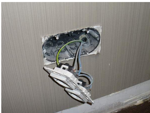
Preparación (desmontado) y tratamiento interior (insecticida de contacto) de puntos eléctricos. (Fotografías Rentokil-España)
