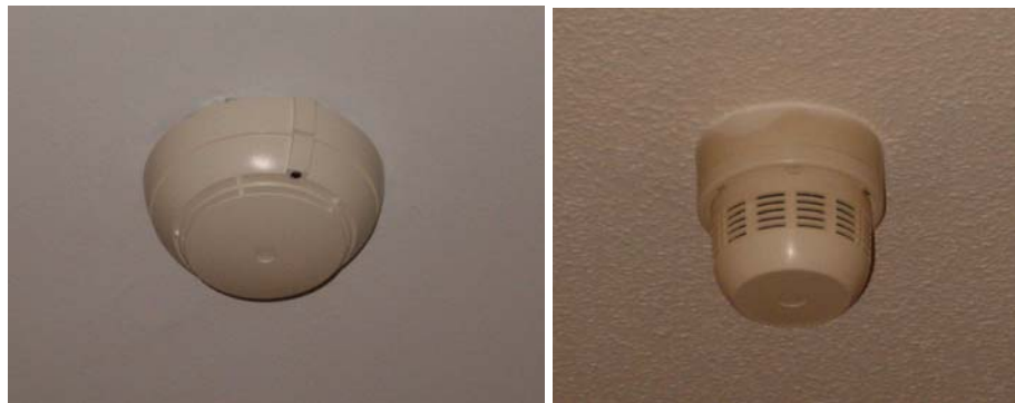
Detectores de seguridad (incendios).
