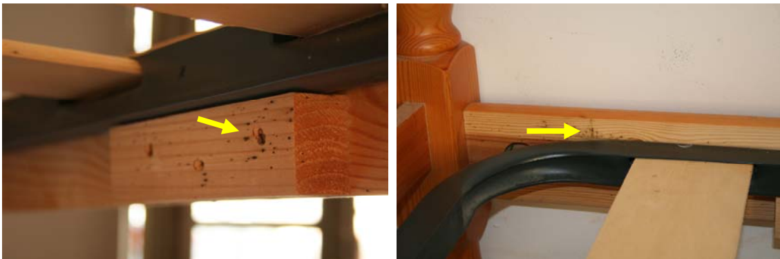
Chinches; Spots fecales sobre la estructura de madera. (Fotografías UTCV-Madrid Salud)
