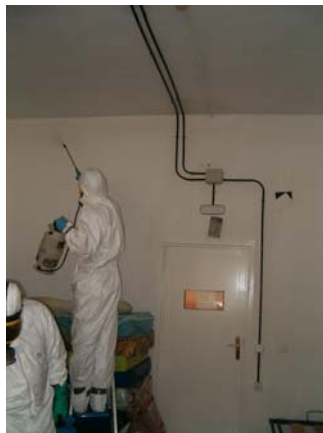
Tratamiento biocida paramentos/otros elementos (Fotografías UTCV-Madrid Salud)
